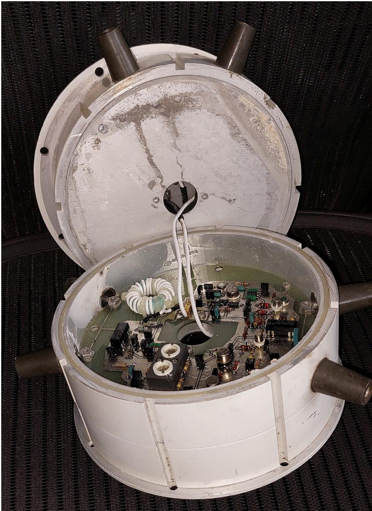
Hier ein Foto der mittleren Einheit vor dem Reinigen. Man kann 2 Relais erkennen: im stromlosen Zustand sind die Antennenelemente direkt mit der Ausgangsbuchse verbunden. Zusätzlich ist die Elektronik durch Überspannungselemente geschützt.
